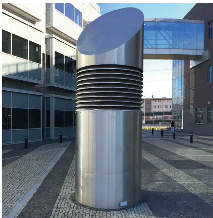
Ventilacijski toranj napravljen od brušenog nehrđajućeg čelika u Jagiellonian Centru za inovacije u Krakovu.
