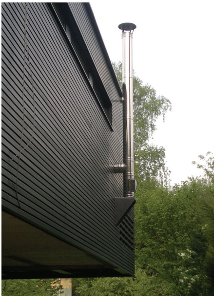
Izolirani segmentni dimnjak DW-FU montiran na pročelju zgrade.
