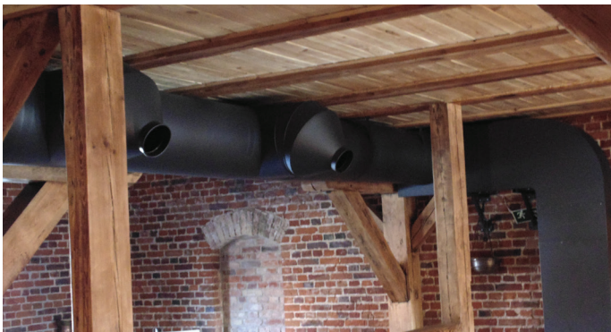
Instalacija mehaničke ventilacije u restoranu izrađena od nehrđajućeg čelika, plastificirane površine cijevi.
