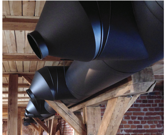
Instalacija mehaničke ventilacije u restoranu izrađena od nehrđajućeg čelika, plastificirane površine cijevi.
